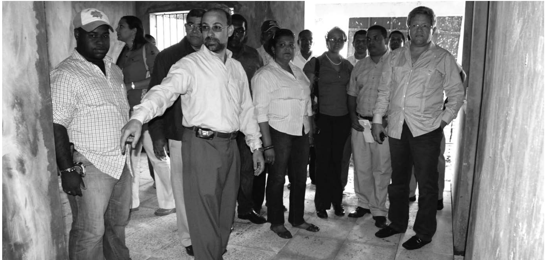
El coordinador ejecutivo de la CERSS, doctor Humberto Salazar, supervisa los trabajos de construcción del Hospital Dr. Felipe Achécar en Pimentel. Le acompañan el encargado de la obra, ingeniero Carlos Báez, y miembros del equipo del Departamento de Infraestructura de la CERSS.
