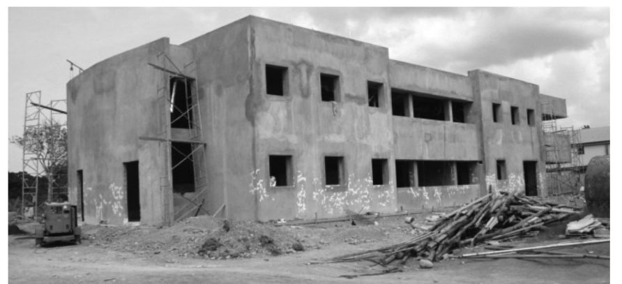
A ritmo acelerado marchan los trabajos de construcción del edificio que alojará a la Regional III de Salud
